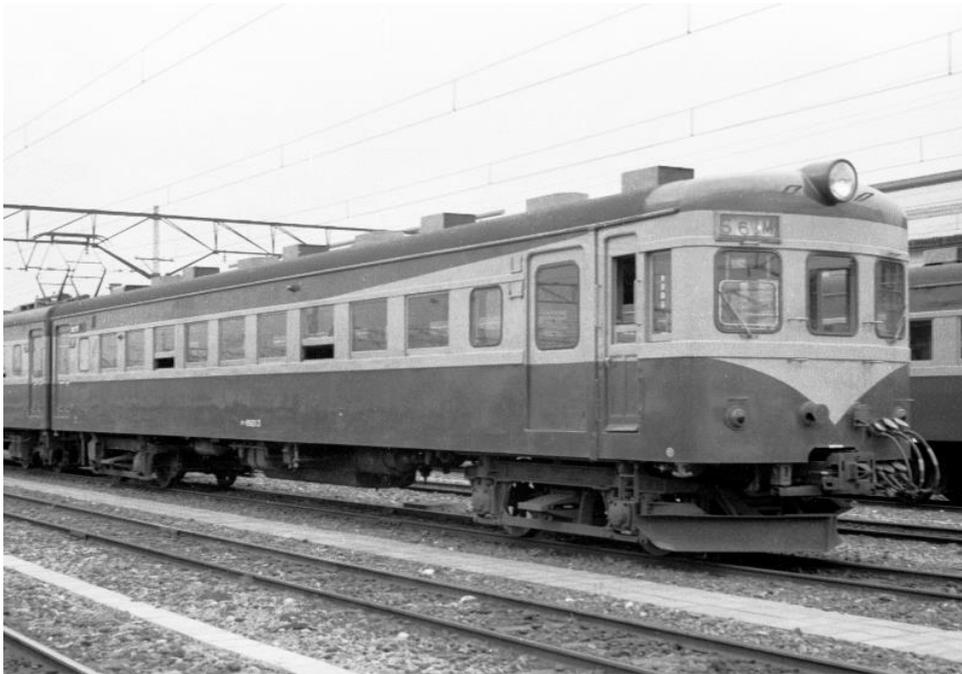
最初に登場した1949（昭和24）年度製の先頭車（か86形）の前面は半流形で3枚窓でした。（か86001～20号車。）
